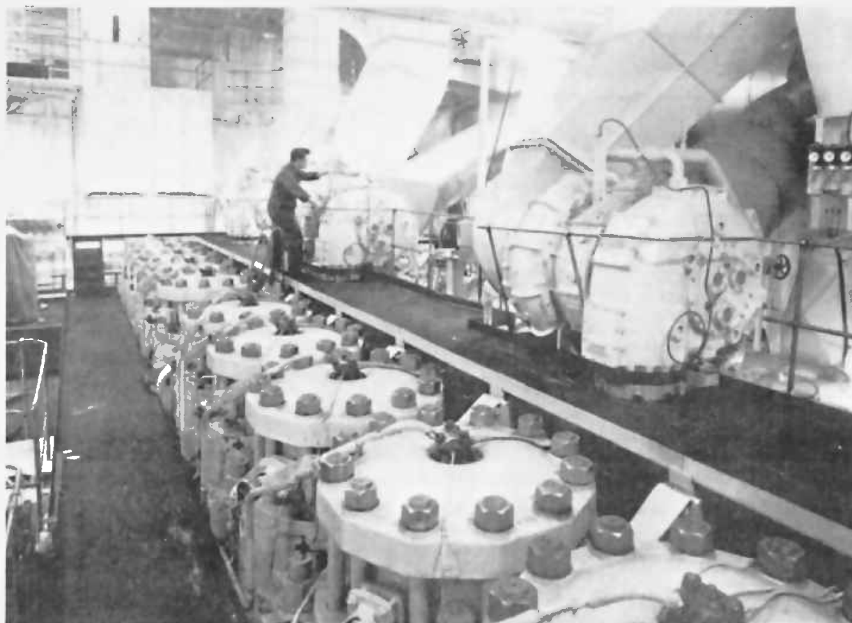
Kockums första byggda överladdade motor typ K10Z78/140C på 11.250ehk-115rpm på nybygge nr 390 m/t BUTMAH
